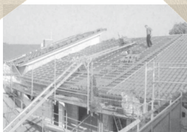
01.06.2004 Haus 5 wird gedeckt.
