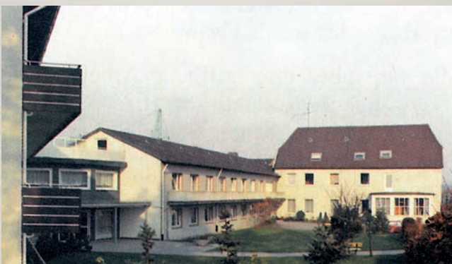
Vor dem Umbau 1992: vlnr. Stammhaus, Pflegeheim 1962 und Anbau 1972
