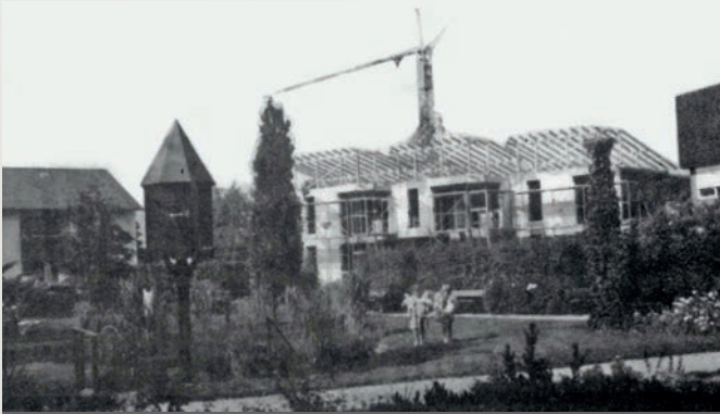
Das Betreute Wohnen entsteht – man erkennt den gerade fertigen Dachstuhl mit dem Krahn im Hintergrund
