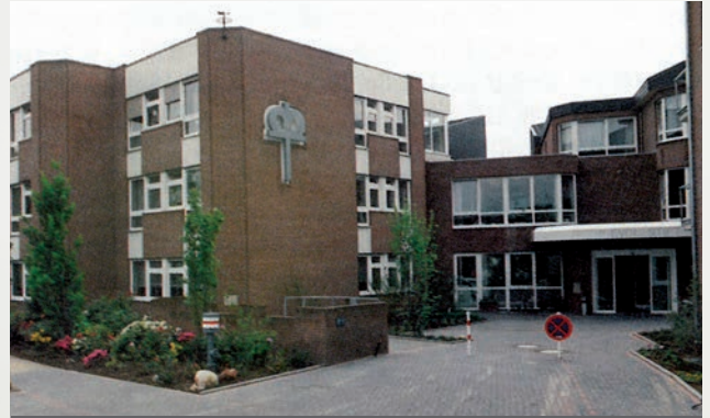
Der frisch fertiggestellte Neubau des Betreuten Wohnens 1990
