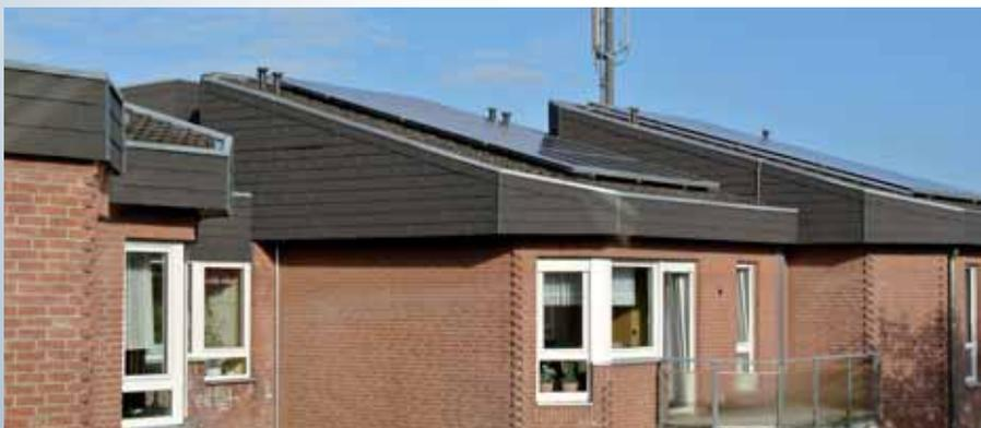
Auf dem Dach des Betreuten Wohnens ist eine Solaranlage installiert. Sie besteht insgesamt aus 76 Modulen. Ein Solarmodul wandelt das Licht der Sonne direkt in elektrische Energie um.
