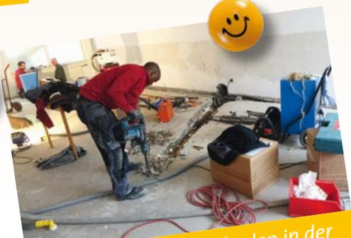
Durch den Wasserschaden in der Bodenplatte wurden die Rohre stark beschädigt und mussten ersetzt werden.
